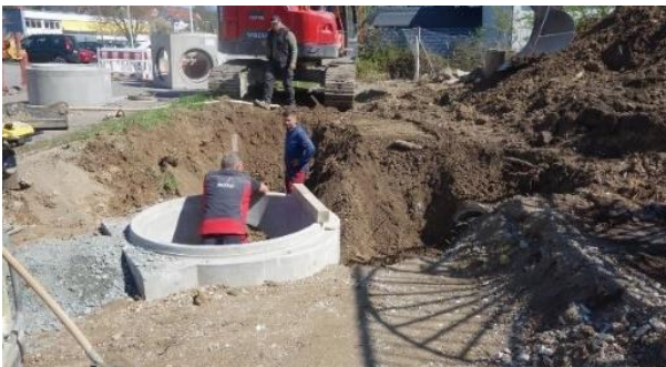
Verlegung des Rehlingsbachs
