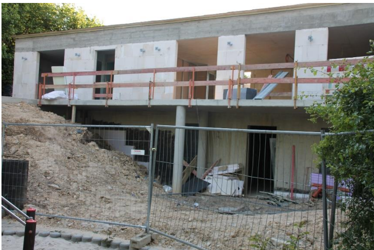
Ende Mai 2022: Blick vom Freibad auf die neue Rettungswachstation
