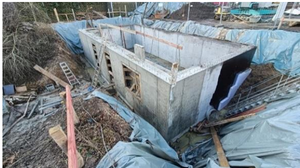
Kellergeschoss im Januar
