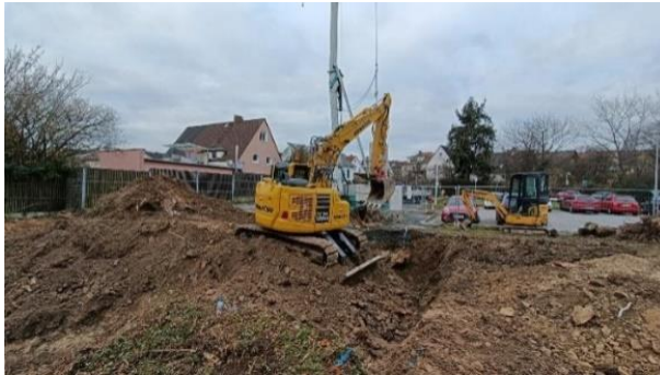
Aushub der Baugrube
